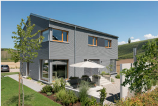
Bild 2: Aktuelles Fertighaus. (Quelle: SchwörerHaus)
