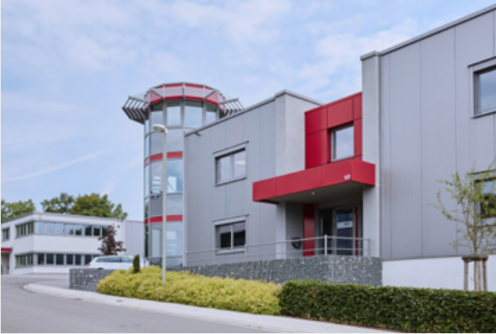
Bild 22: Standort air-lab. (Quelle: air-lab GmbH)
